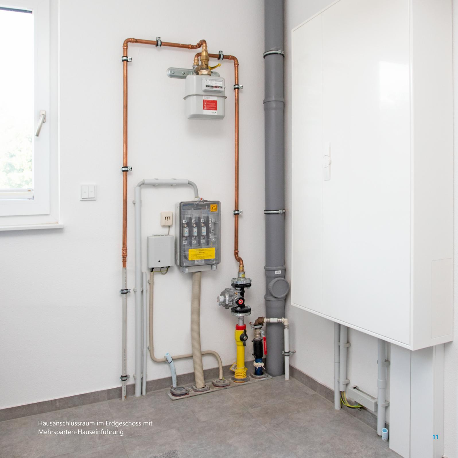
Hausanschlussraum im Erdgeschoss mit Mehrsparten-Hauseinführung
