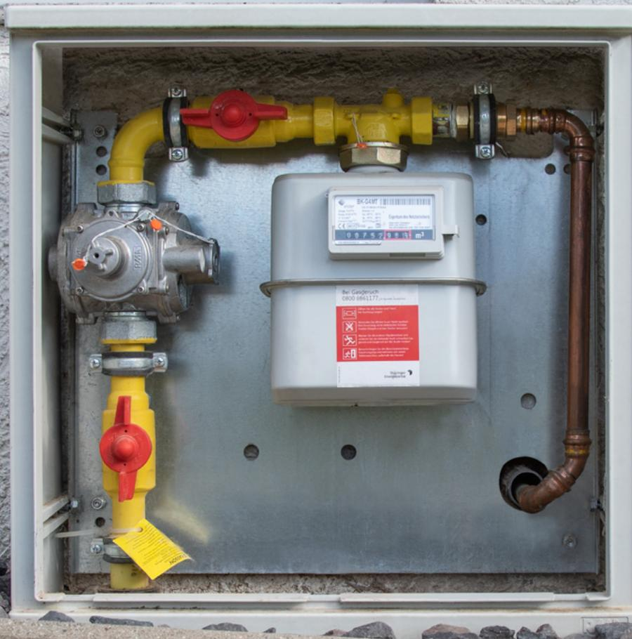
Erdgashausanschluss mit Hausanschlusskasten, inklusive Hausdruckregelgerät und Gaszähler. Geeignet für Gebäude ohne Keller bzw. ohne geeigneten Anschlussraum.
