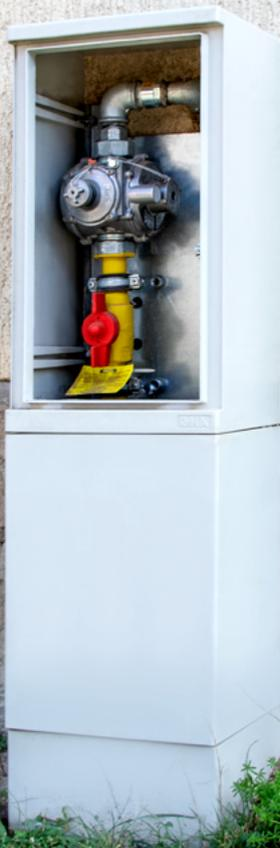
Beispiel eines Hausanschlusskastens für Erdgas ohne Zähler
