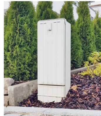
Beispiel einer Hausanschluss säule für Strom
