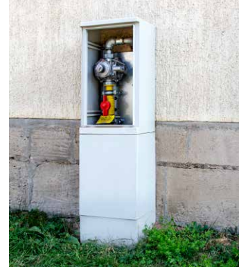
Beispiel eines Hausanschlusskastens für Erdgas ohne Zähler
